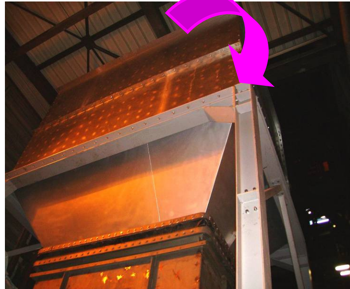
Silencieux de sortie d'air et capotage sur ventilateur
